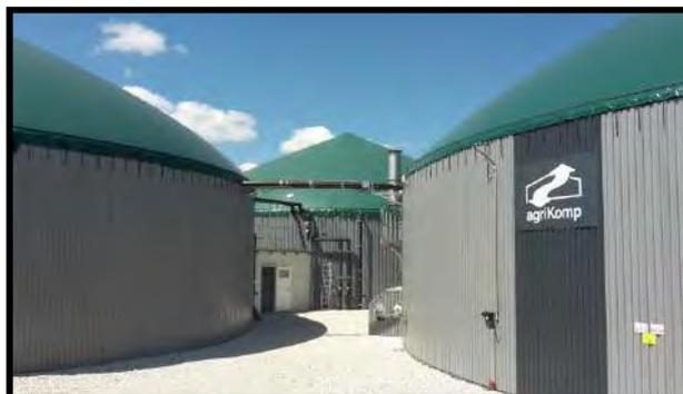
Le Digesteur et le Post-Digesteur disposeront d'une couverture Double-Membrane ce qui permettra d'augmenter l'autonomie de stockage. Grâce aux 2 gazomètres, l'installation pourra stocker un volume total de 1 686 m<sup>3</sup> de biogaz soit une autonomie de 7 heures environ.
