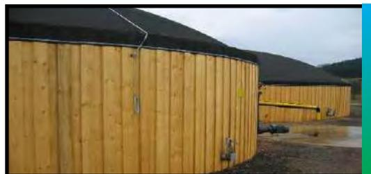
Les digesteurs sont alimentés par pompage depuis la pré-fosse. Les matières solides sont incorporées par un système d'introduction spécialement conçu (Vielfrass).
