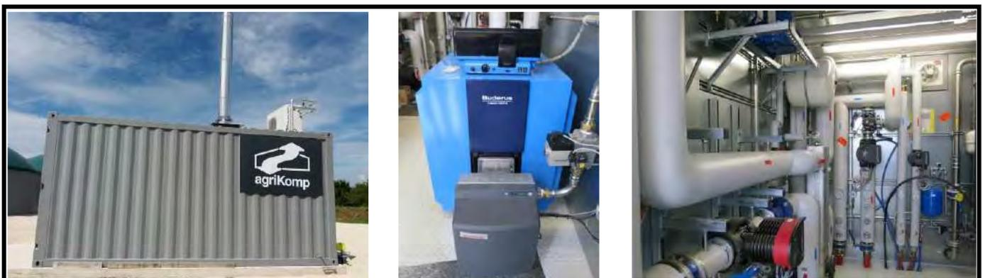
La chaudière disposera d'une cheminée d'évacuation des gaz de combustion et sera raccordée sur la boucle d'eau chaude du système de chauffage du process de production de biogaz (digesteur et post digesteur le cas échéant).
