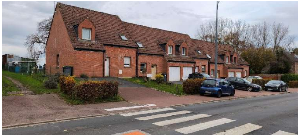
5 logements situés Ch. Brunehaut appartenant à la commune et loués à Partenord par bail emphytéotique
