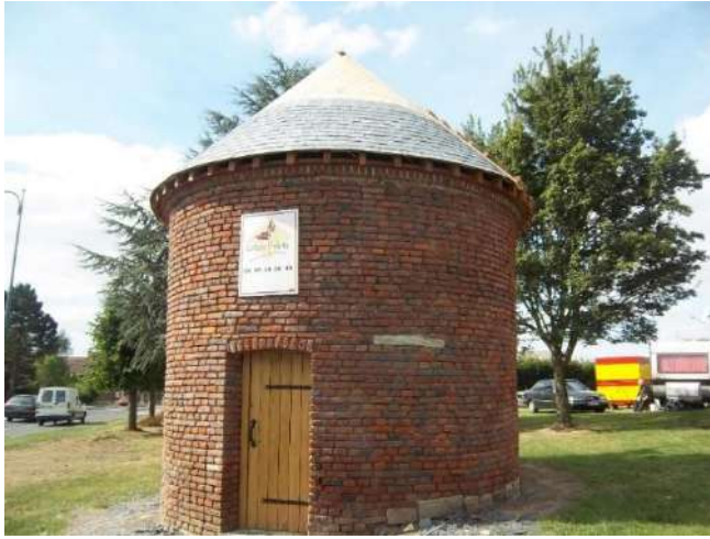
La « Tourette » restaurée
